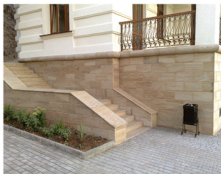
Реставрация памятника архитектуры фа- садной системой «Kings' Stone», АР Крым
