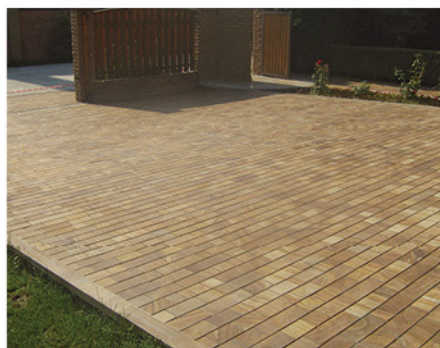
Мощение тротуара шлифованной брусчаткой из кварцито-песчаника, г. Донецк.
