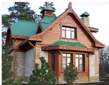
Облицовка дома фасадной системой «Kings' Stone», г. Донецк
