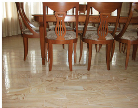
Укладка пола полированной плиткой из кварцито-песчаника, г. Донецк.
