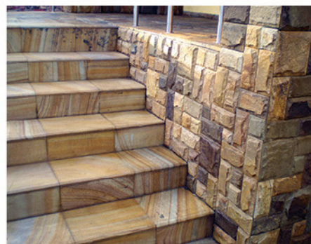
Облицовка ступеней и цоколя облицовочной плиткой из кварцито-песчаника, г. Макеевка.
